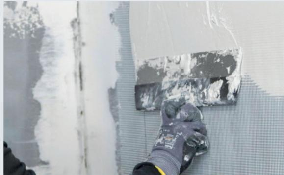
5.5 Presione el Skamol Mesh en el yeso húmedo con un solapamiento de 10 cm.
