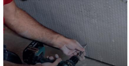
**3** Skamol Torx werden im Abstand von 250–350mm verschraubt.
