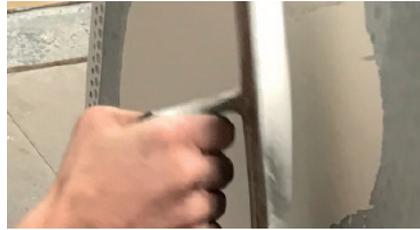
**2** Skamol Structural Plaster oder Skamol Smooth Plaster anmischen und dort auftragen, wo die Skamol Corner positioniert werden soll.
