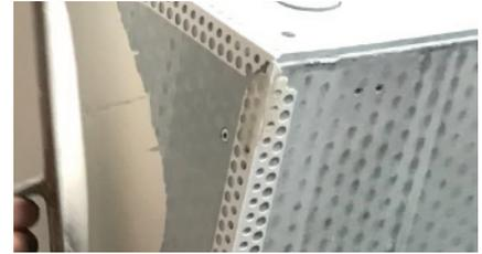
**3** Die Skamol Corner in den Putz drücken. Überschüssiger Putz wird geglättet.
